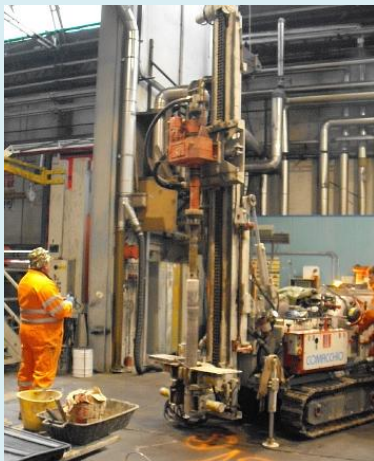
sondaggio di caratterizzazione in sito industriale
